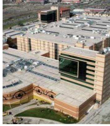
Kuyumcukent CCTV Projesi
